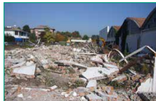
Ex Grosoli, iniziata con le demolizioni la fase di riqualificazione
