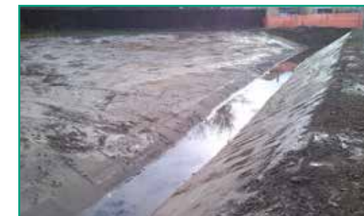
Lavori in corso per la riqualificazione degli scoli delle acque superficiali
