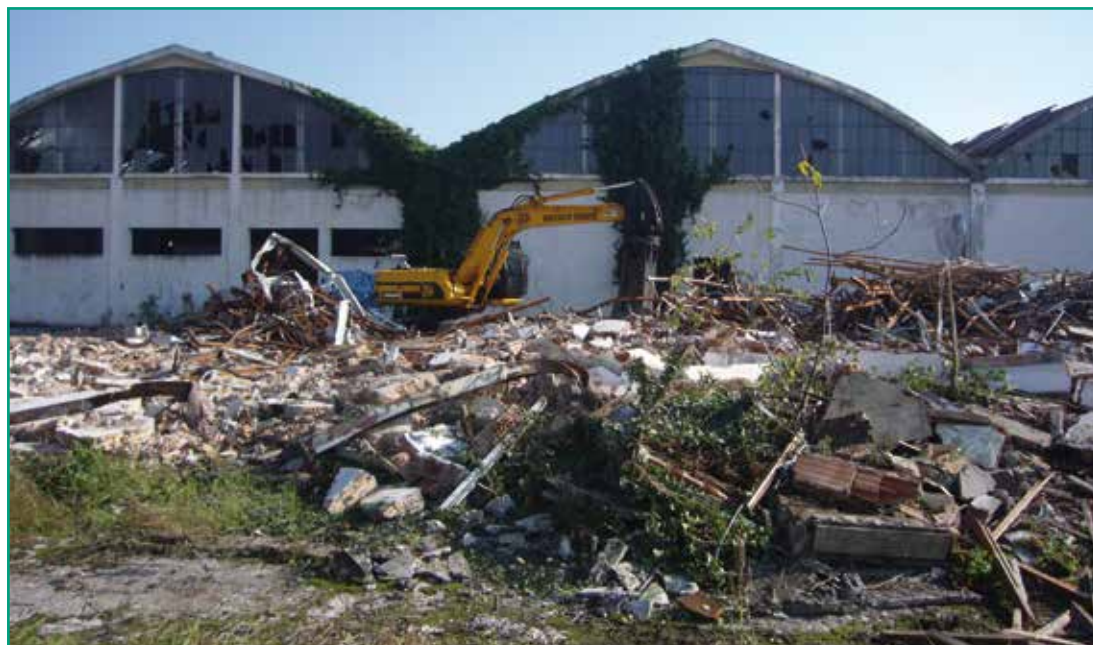
Ex Grosoli, i lavori di abbattimento e sgombero dei vecchi edifici
